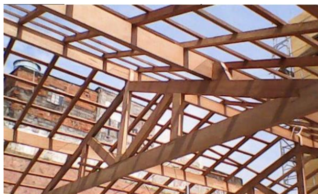
Figura 29 Tesoura no telhado
