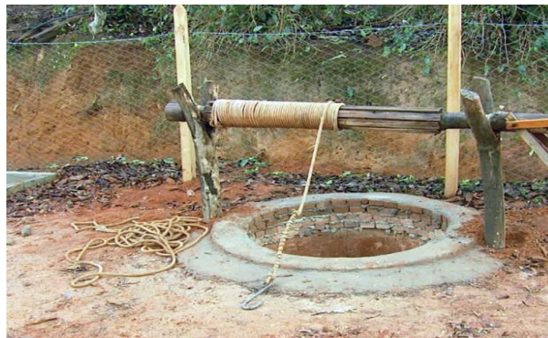
Figura 14 (2) Construção de cisterna
