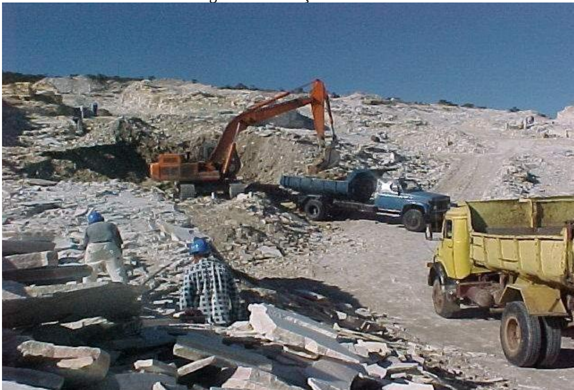
Imagem 6 – Remoção do estéril.
