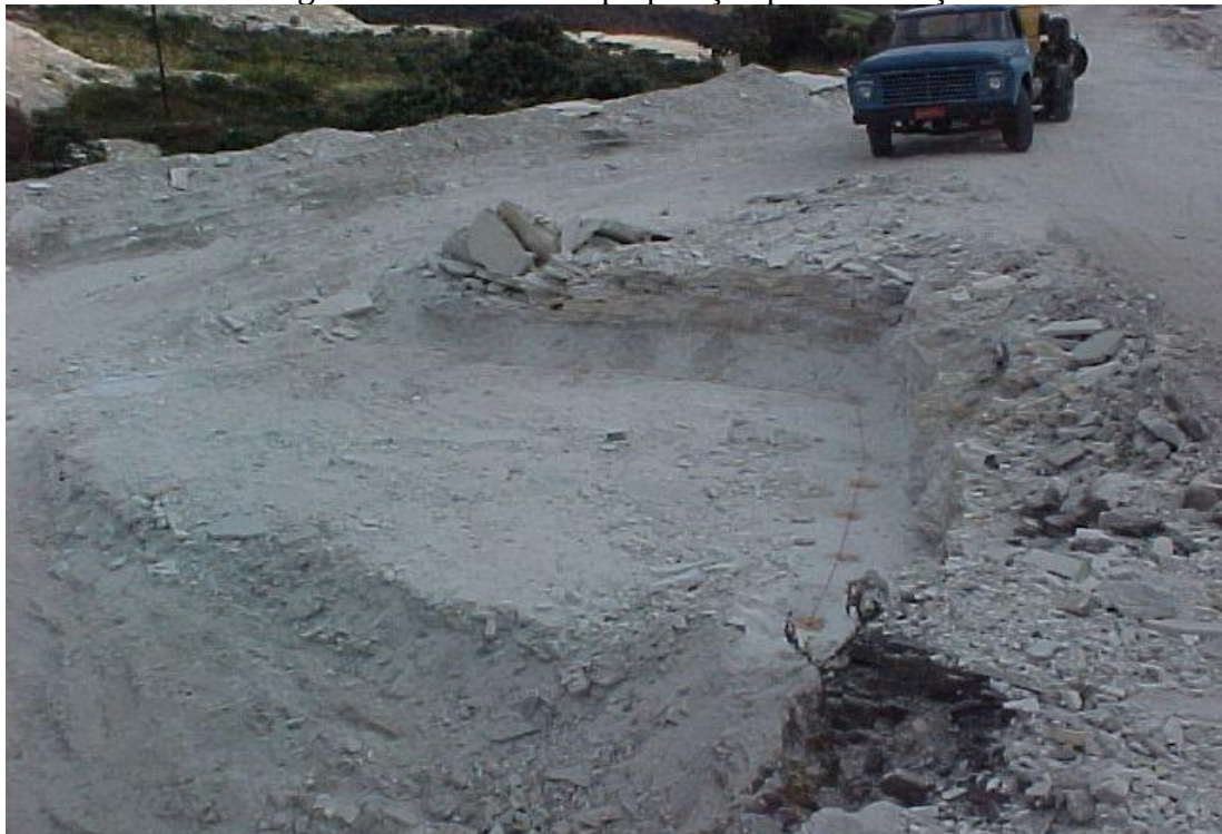
Imagem 4 – Desmonte – preparação para detonação.
