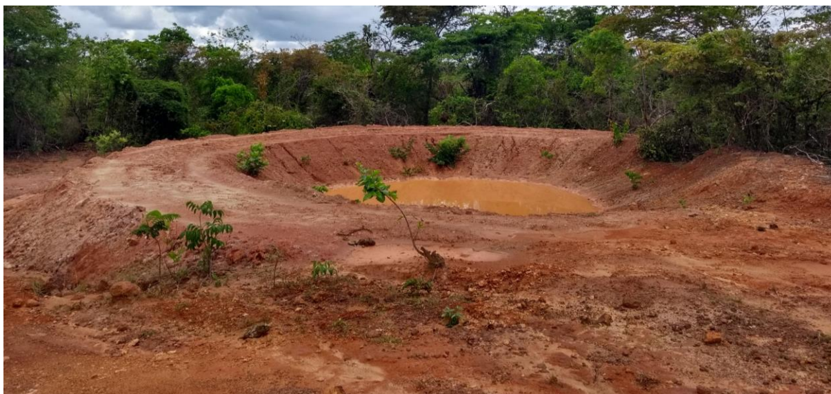
Figura 9 – Exemplo de prática conservacionista mecânica: bacia de infiltração construída na APA Pandeiros.
